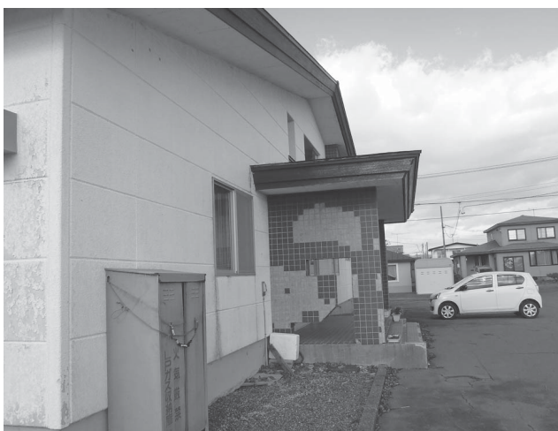
老朽化している白老生活館
