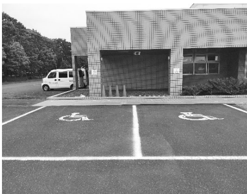
総合保健福祉センターの駐車場
