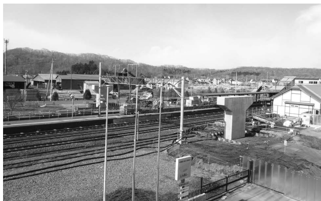
建設中の白老駅自由通路
