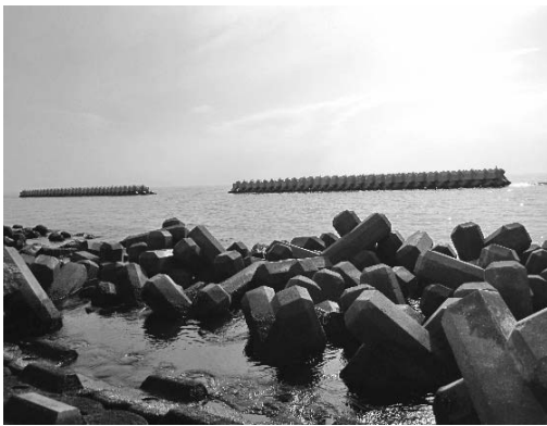
アヨロ海岸付近の離岸堤工事
