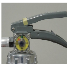
× 安全栓の脱落
