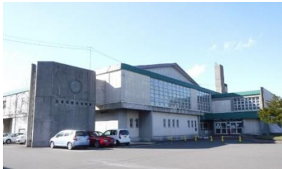
白老町総合体育館
