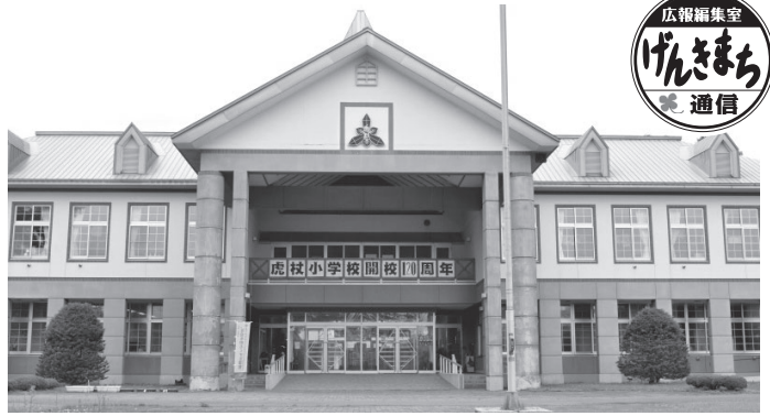
1998(平成10)年に増改築された現在の校舎
