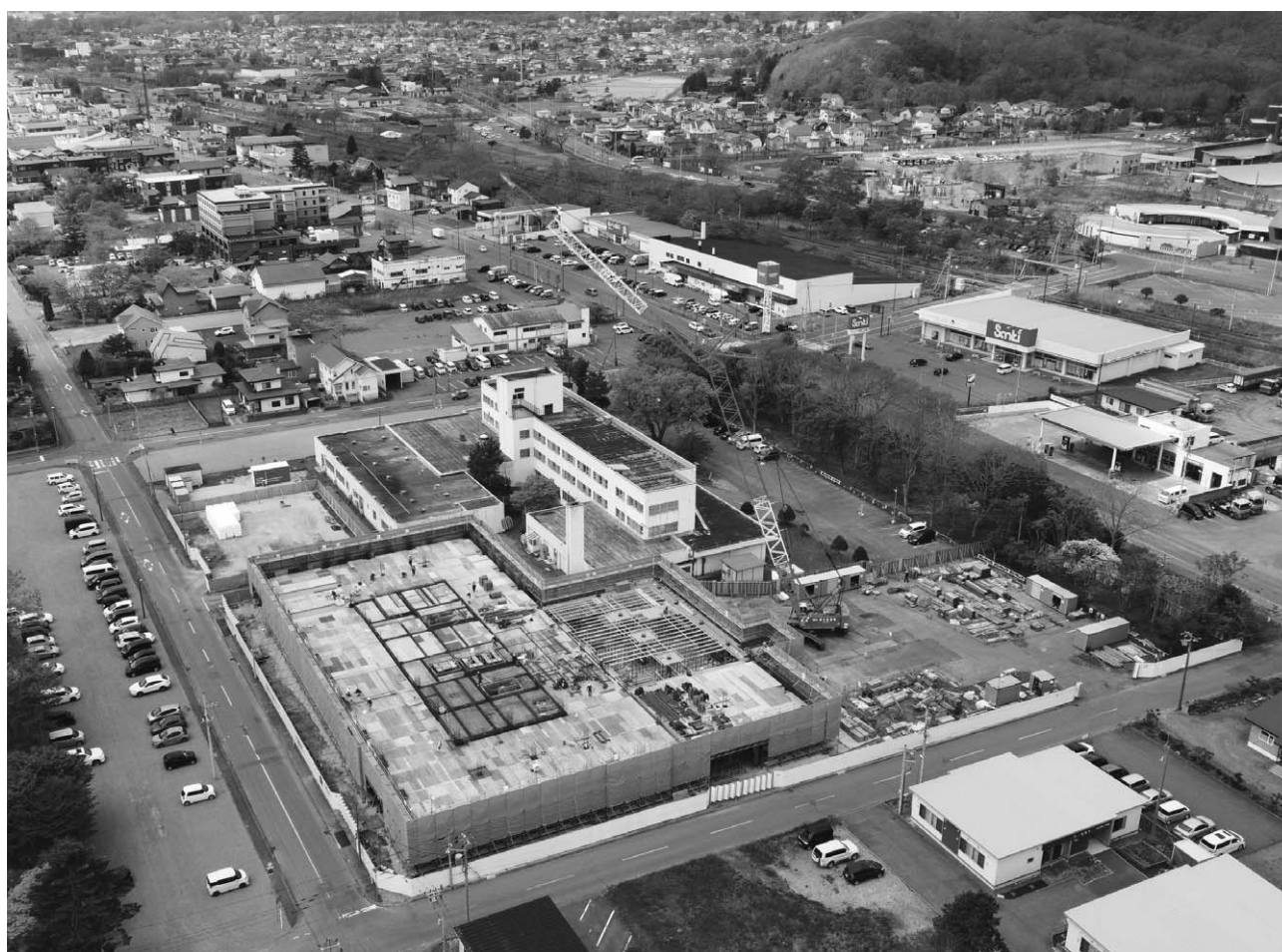
建設が進む町立病院（ドローン撮影）
