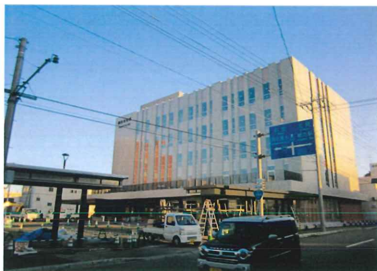
建設工事中の網走市役所・新庁舎
