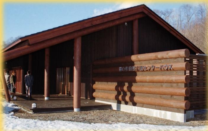
萩の里自然公園に建てられたケネルハウスの外観
