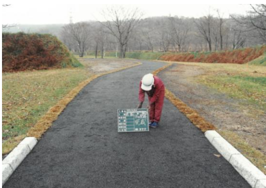
大手御門付近の防塵舗装（灰色範囲）
