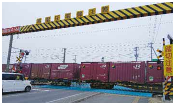
避難等の緊急時は踏切の開放が必要
