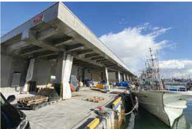
小牧港の屋根付岸壁
